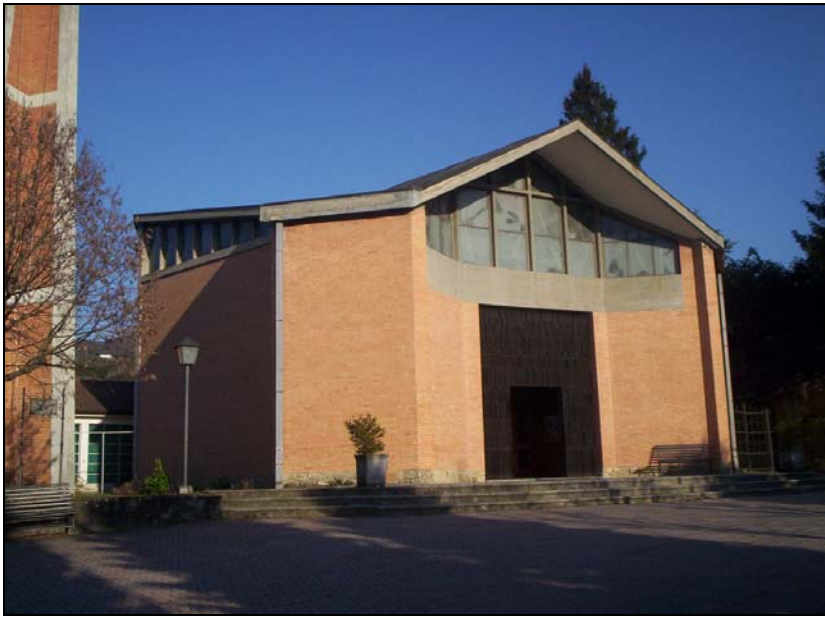
Figura 17 Chiesa parrocchiale di Ponte Nizza.
