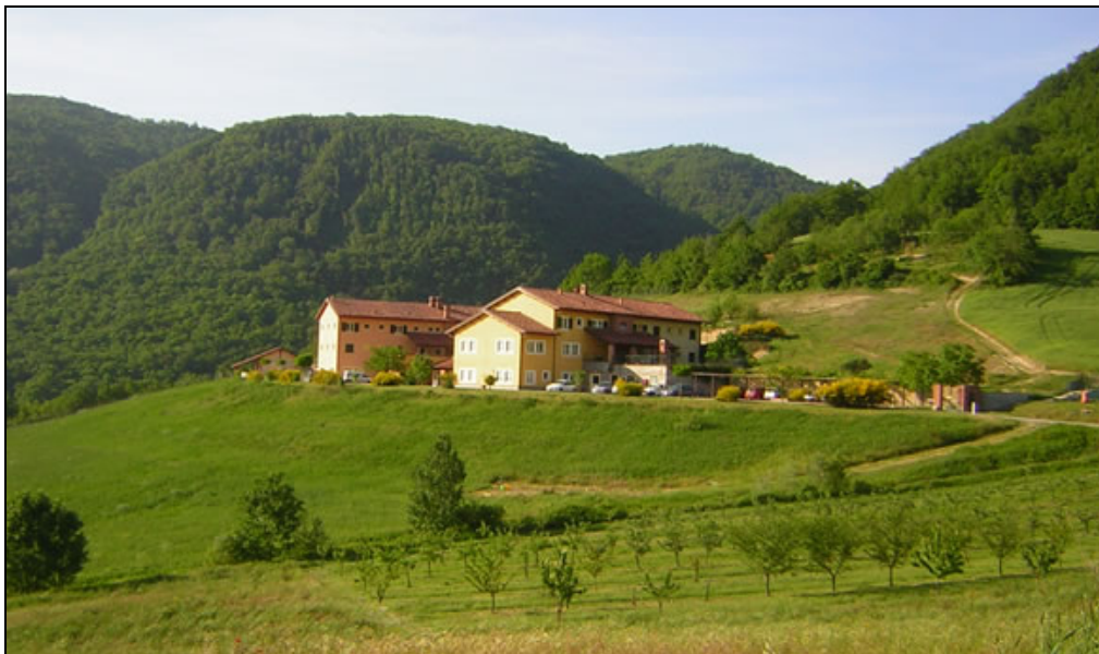
Figura 19 Residenza Sanitario Assistenziali per Disabili “Cascina Rossago”.
